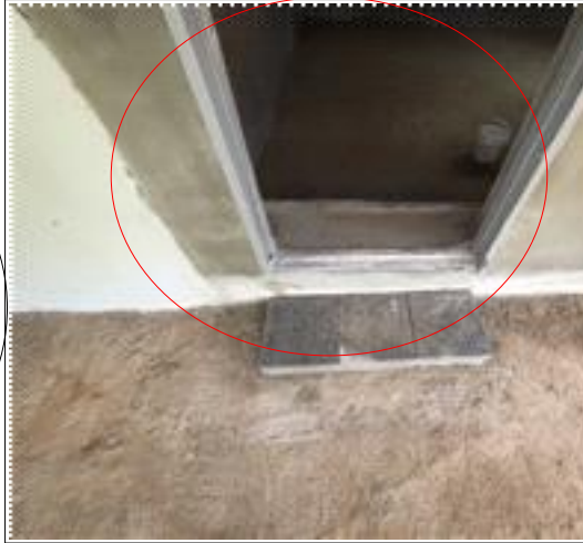
<사진2> 새로 시공된 문틀
