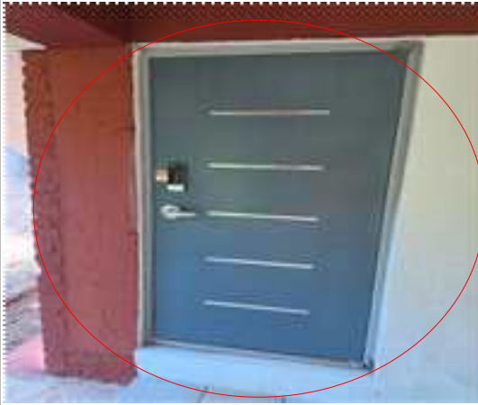
<사진1> 기존 시공된 문틀
